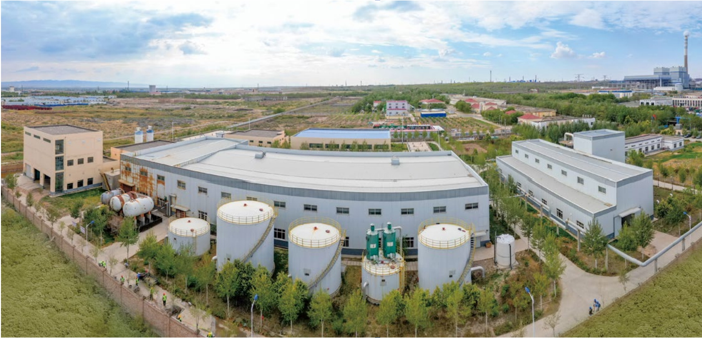
■ 宁夏中卫高效零排放项目 25,000 m 3 /d 污废水再生及零排放
