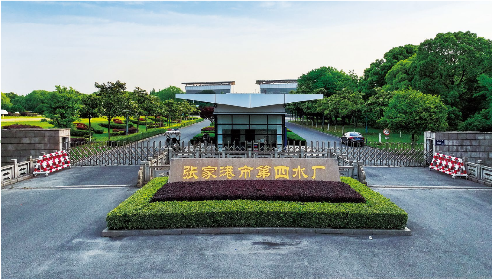
■ 张家港第三、第四水厂 纳滤深度处理项目 产水规模：400,000 m 3 /d 核心工艺：SlightPol 微污染源高品质供水工艺技术包
